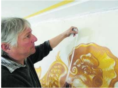
Bela Farago in schwindelnder Höhe über dem Medaillon des Chorbogens. Er hat das Japanpapier in Streifen geschnitten und presst es in den Riss, als elastische Verbindung.
